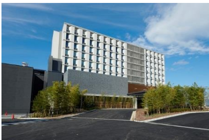
「HOTEL CLAD」 外観
